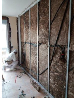
Paso 2: aislante e instalaciones
